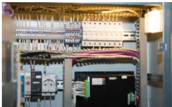
Верх шкафа управления
