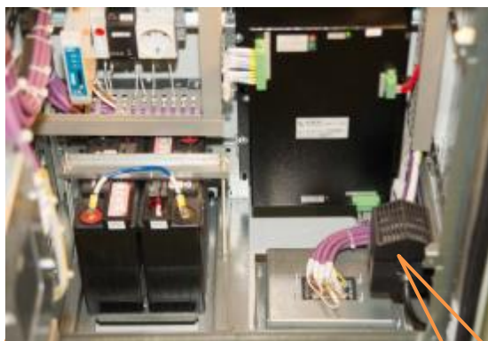
Низ шкафа управления
