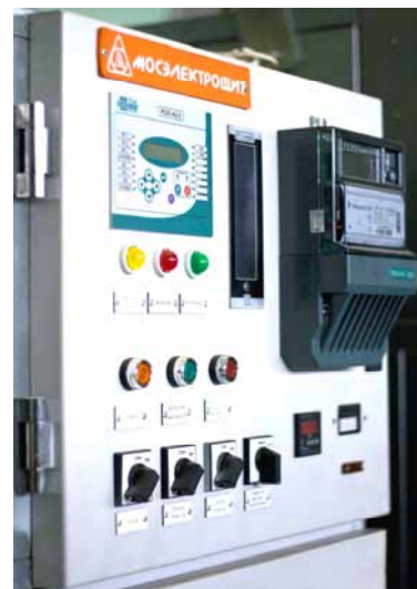
Рис 7 Релейный отсек.
