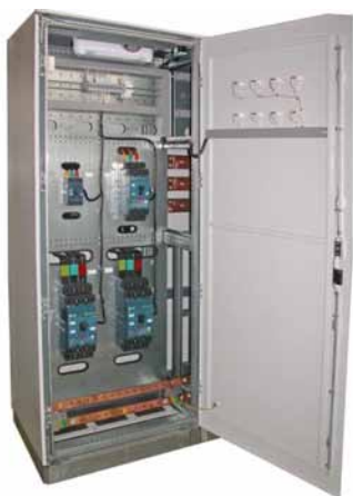
Рис. 11. Общий вид шкафа ШНН.
